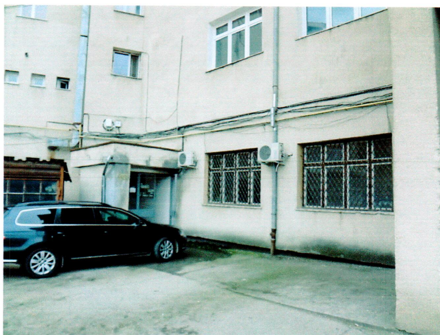
Figura 4. Termoizolarea pereților exteriori de pe fațadele N, N-E și N-V este posibilă numai în cazul termoizolării întregii elevații a fațadei
